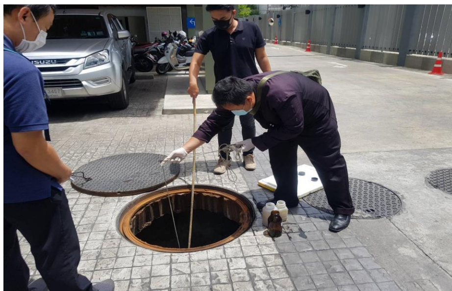
ภาพที่ 5.1.1 การเก็บตัวอย่างน้ำเสีย ก่อนเข้าระบบ
